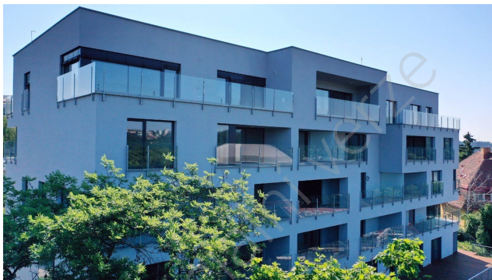
Obrázek 1 Fotografie realizovaného projektu „Novostavba domu Hippokrates“.
