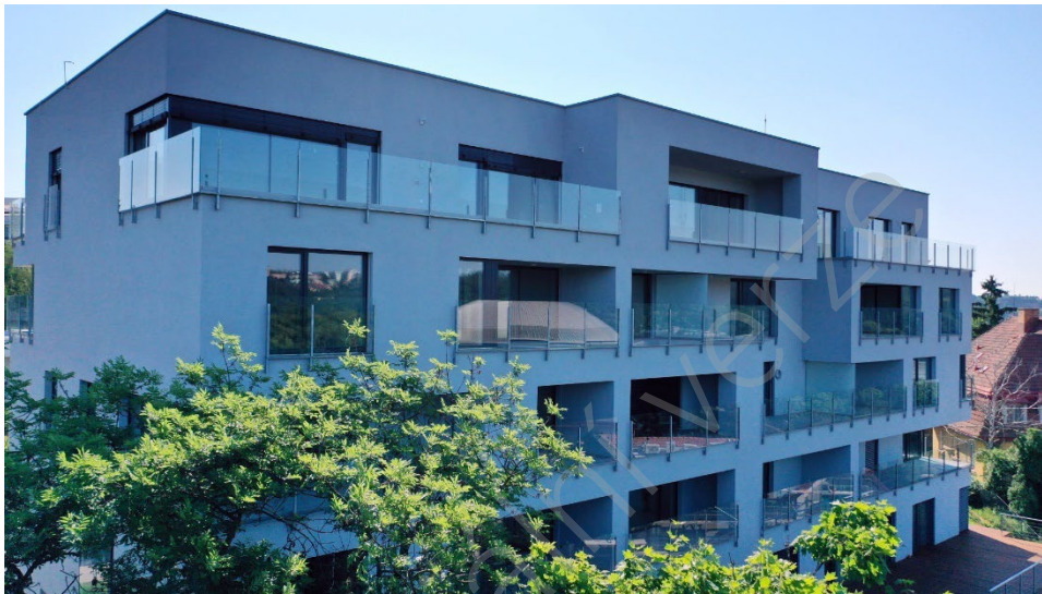
Obrázek 1 Fotografie realizovaného projektu „Novostavba domu Hippokrates“.
