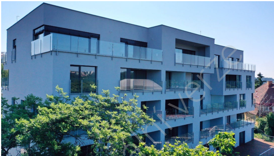
Obrázek 1 Fotografie realizovaného projektu „Novostavba domu Hippokrates“.
