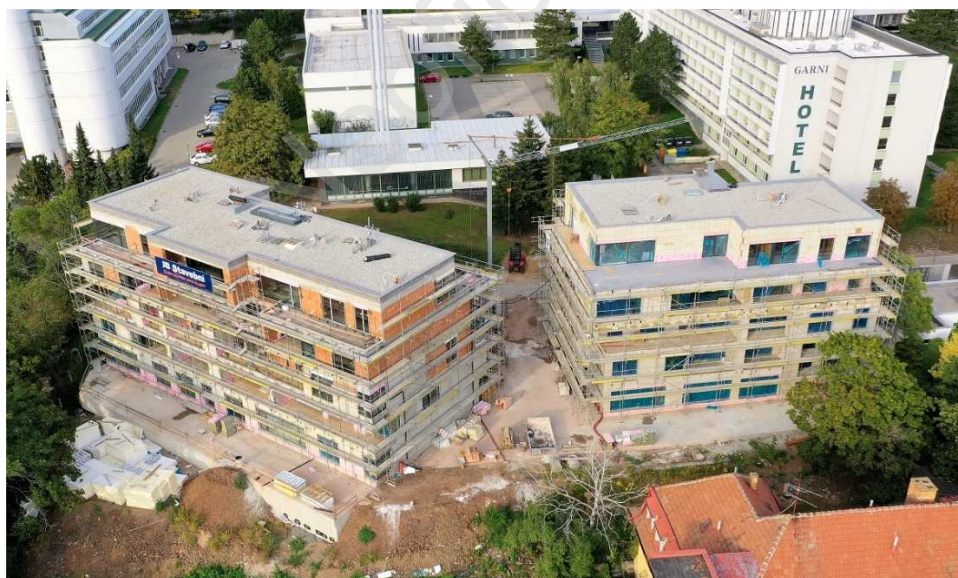
Obrázek 2 Fotografie z realizace developerského projektu „Novostavba domu Hippokrates“ z 9/2020.
